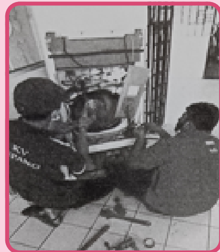
Kerja-kerja memasang penghawa dingin
