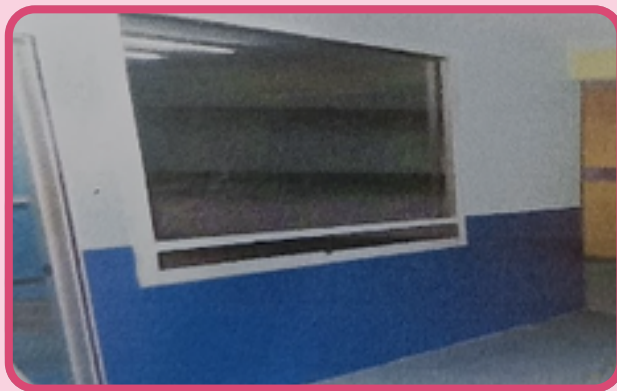
Kerja-kerja penstrukturan ruang kerja partition selepas
