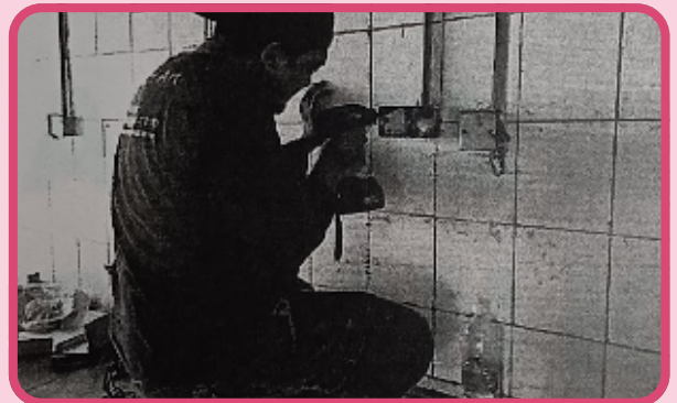
Kerja-kerja mengalihkan suis
