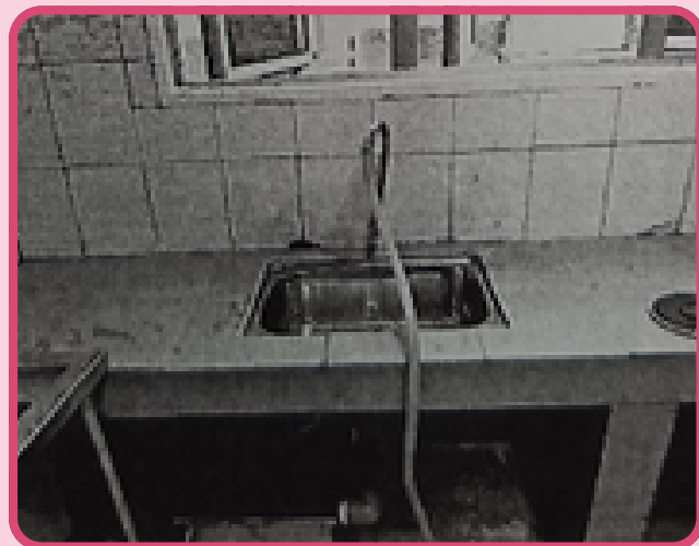
Kerja-kerja menukar double sinki ke single sinki
