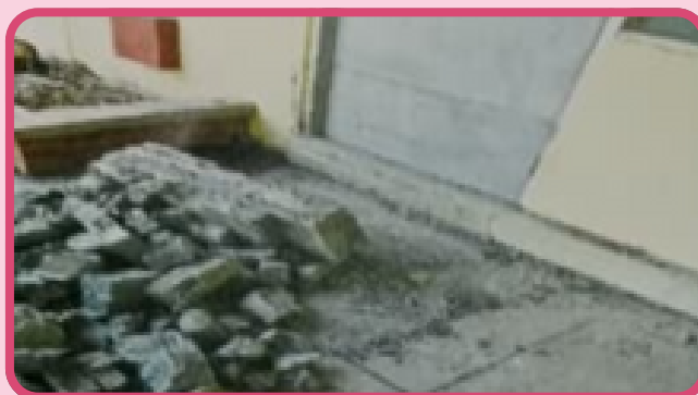
Kerja-kerja memecah konkrit sedia ada yang menghalang pintu
