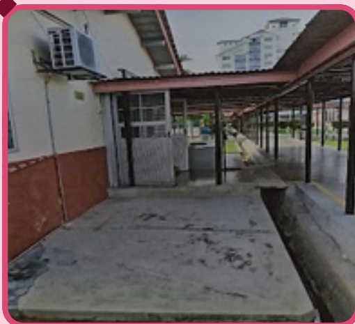
Kerja-kerja penyelenggaraan stor alatan sebelum
