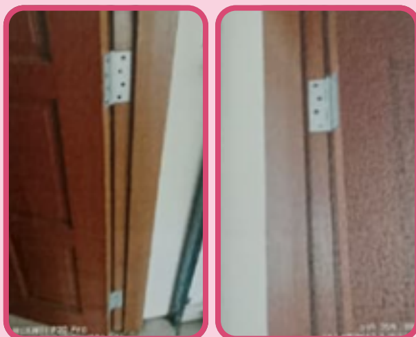
Kerja-kerja pembaikan frame pintu dan engsel pintu utama yang tersangkut
