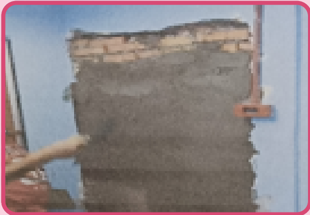
Kerja-kerja penstrukturan bilik operator (penutup dinding pintu lama) sebelum
