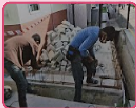
Kerja-kerja penyelenggaraan stor alatan semasa
