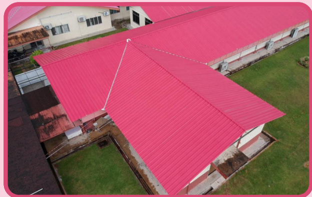
Kerja-kerja penggantian bumbung selepas
