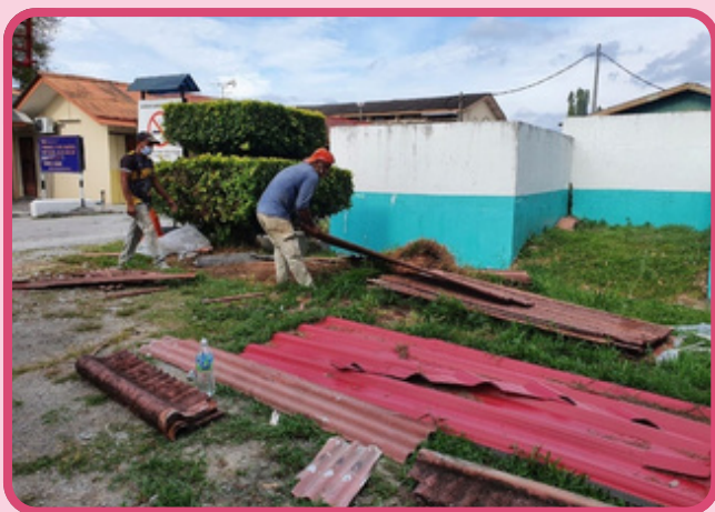
Kerja-kerja memungkah bumbung asbestos untuk dilupuskan
